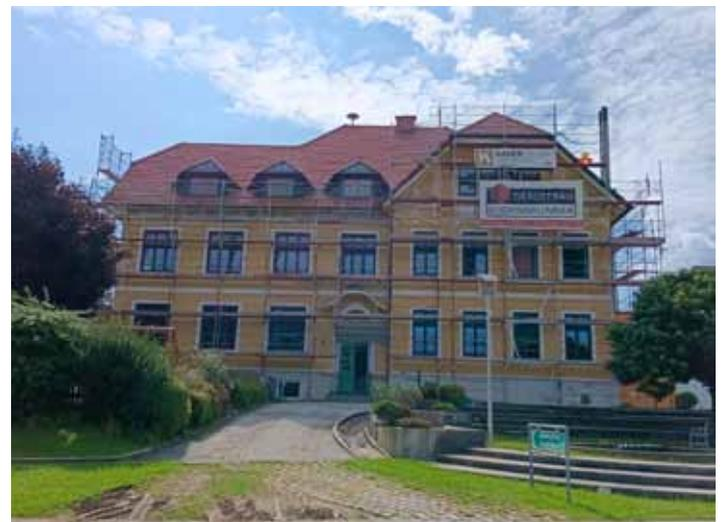
verstärkt. Straßenseitig, wo die Fenster in einem deutlich schlechteren Zustand waren als beim restlichen Objekt, wurden diese erneuert und dafür wartungsarme Kunststoff-Alu-Fenster verwendet. Die restlichen Fenster wurden überprüft und erforderlichenfalls neu abgedichtet. Dies alles erfolgte in ei-
